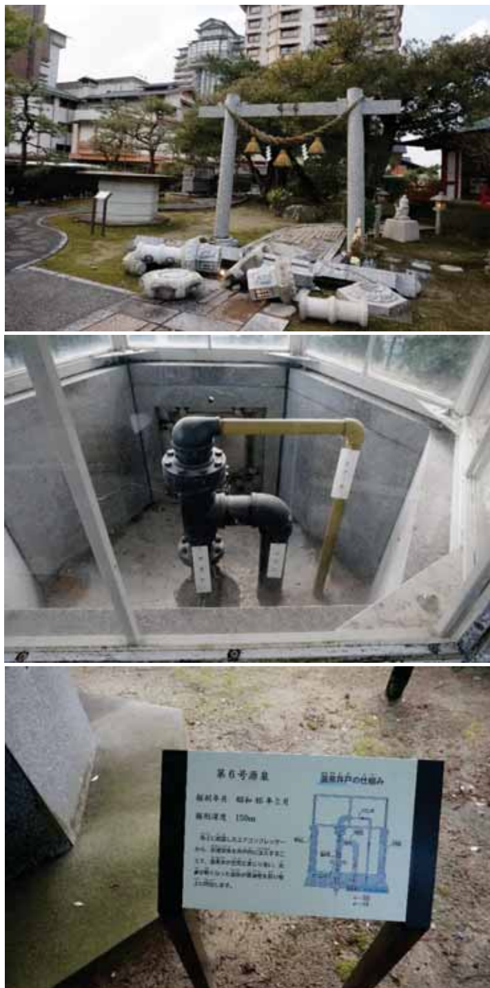
七尾市立弁天崎源泉公園（灯籠の倒壊、稼働を休止する井戸とその看板）
