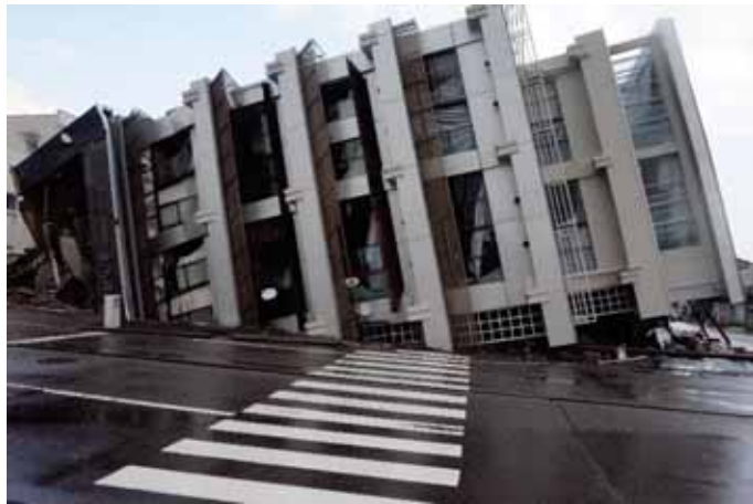
輪島市街地における建物の倒壊
