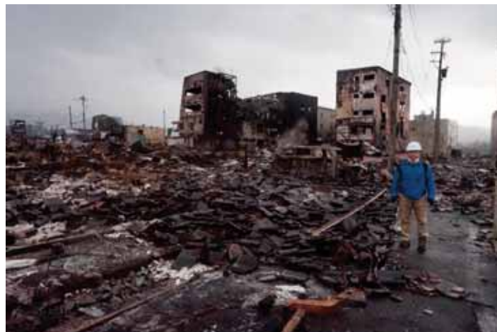
旧朝市の火災跡（甚大な被害）
